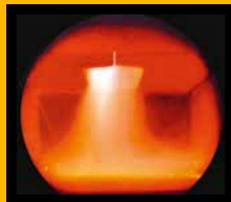
En esta imagen térmica se puede ver la fuerza con la que entra la mezcla de aire y gas en la cámara de combustión incandescente. Se forman turbulencias que logran una combustión completa con muy poco residuo.
